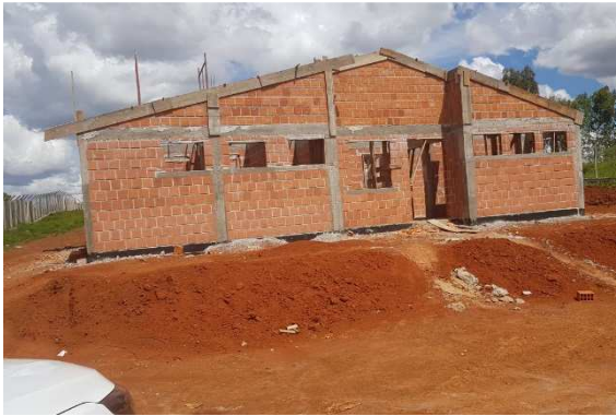
Figura 1– 07/11/2018 – vista frontal da obra
