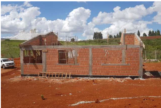
Figura 3– 07/11/2018 – vista lateral da obra
